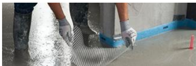
Figure 4 : Pose d’un renfort d’angle
